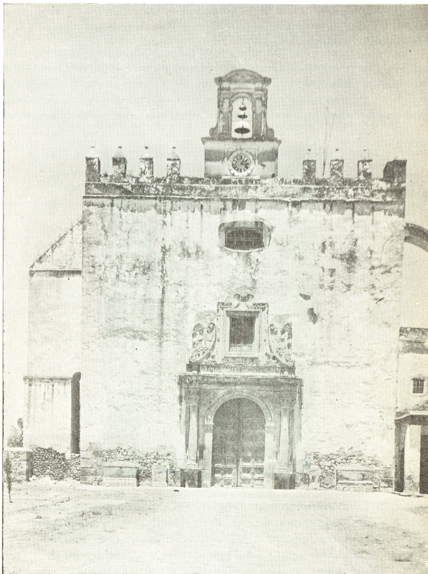
Entrada principal a la iglesia, enmarcada por elementos arquitectónicos labrados en piedra. Nótese la desproporción que guarda la espadaña y el reloj con el cuerpo de la fachada.—San Bernardino, Xochimilco, D. F.
