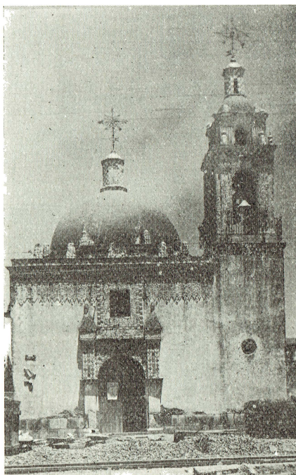
Capilla del Rosario. Fachada principal decorada con "labores de argamasa" combinada con azulejos amarillos y azules.— Xochimilco, D. F.
